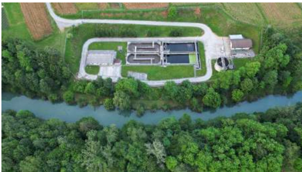
Centralna čistilna naprava Vojna vas (Črnomelj)
